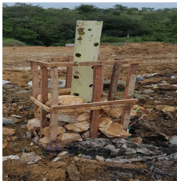
FOTOGRAFIA: Parte terminal Chimenea LUGAR: Zona – Cella IV de la Fase II
